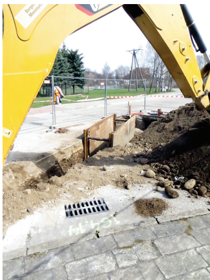
Budowa sieci kanalizacji sanitarnej ul. Pogodna.
