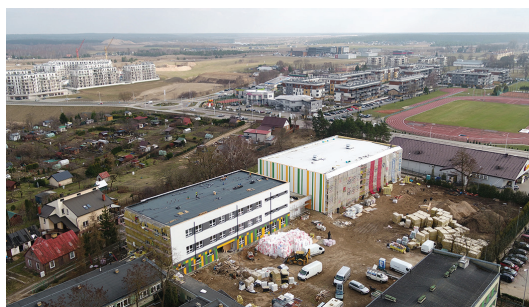
Rozbudowa Szkoły Podstawowej nr 4 w Suwałkach.
