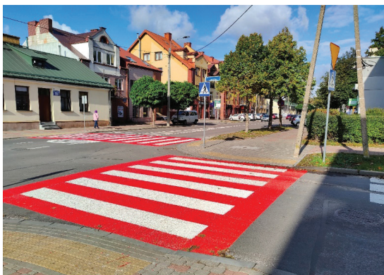
Oznakowanie poziome przejść dla pieszych na tle czerwonym oraz przycisk wibracyjny.
